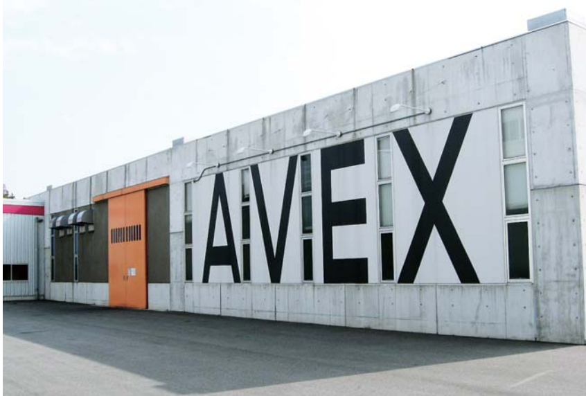
三重県桑名市にあるエイベックス(株)多度工場は、三千坪の広大な敷地に建設されている。
