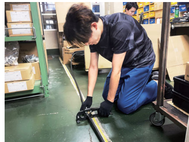
ホース切断作業(イノウエ商会)
